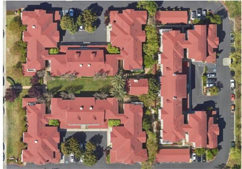
Casa del Maestro, aerial view, 2022
